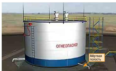
Рис. 1. Мертвая полость резервуара РВС-400
